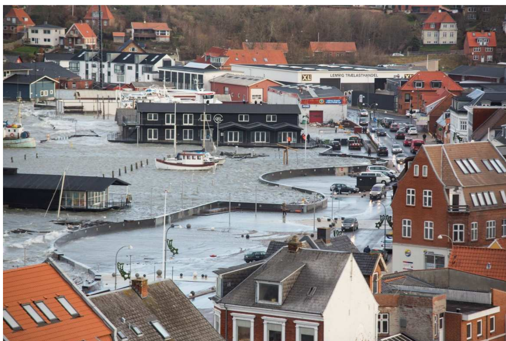
Figur4.1 Lemvig Havn under stormen Bodil. Bemærk stormflodssikringen eller højvandsværnet, der som en mur slynger sig gennem havnelandskabet og opdeler pladserne i tørre og våde arealer. Ved stormen den 5. og 6. december 2013 nåede den ekstreme vandstand rekordhøjde på 1,83 meter.
