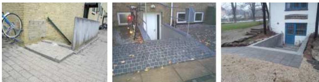
Figur 2.1 Hævede kanter med terrænreguleringer til sikring af gode afgangsf forhold. Terrænreguleringer skal udformes med respekt for tilgængelighedskrav.
